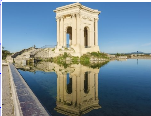
Château d'Eau du Peyrou, Montpellier
